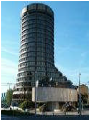
BIS Tower Building, Basel
